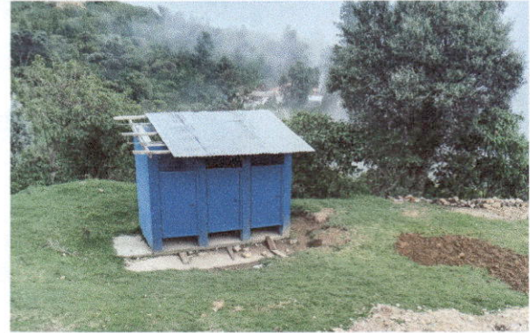
Foto 2: Lijado a plicacion de pintura puertas sanitarios.
