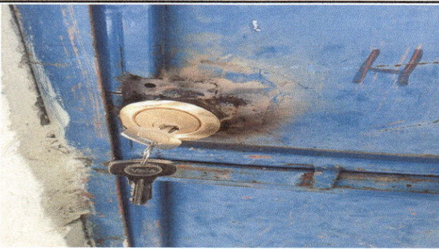
Foto 5: Sustitucion de Chapa
