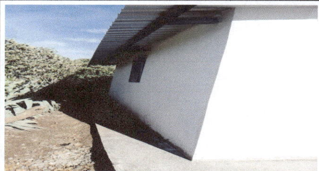
Foto 6: Reparacion de Muro sustitucion de ventana y balcon.
