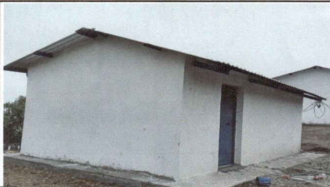
Foto 3: Bodega sustitucion de lamina, techo y repello de pared.
